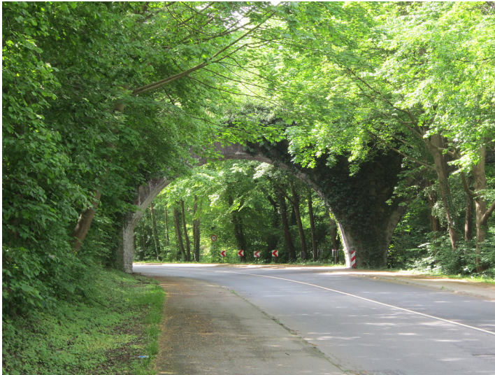
Angertalbahn, Brücke über die Flandersbacher Straße bei Wülfrath (2015) Fotograf/Urheber: Claus Weber
