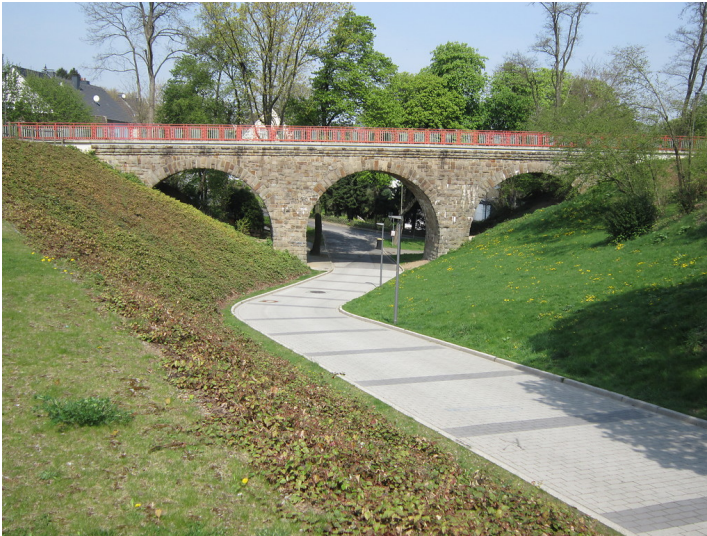
Heiligenhaus, Niederbergbahn, Brücke am Hefelmann-Park (2017) Fotograf/Urheber: Claus Weber
