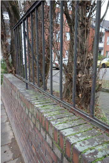
Mauer als letzte Erinnerung an die Brauerei Rheingold (2016) Fotograf/Urheber: Kai-William Boldt
