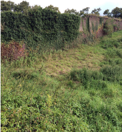
Die überwachsene Klostermauer von Haus Meer (2014). Fotograf/Urheber: Martin Sorg
