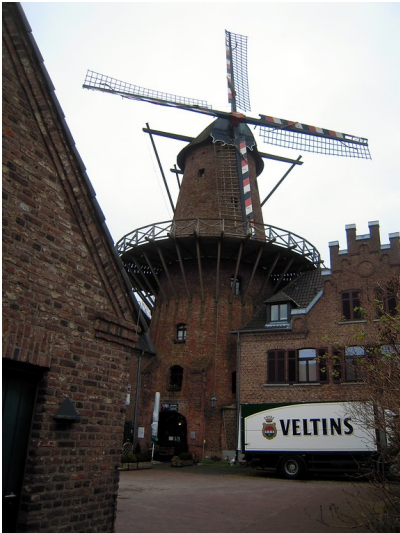
Windmühle am Hanselaerertor in Kalkar (2015) Fotograf/Urheber: Hans-Michael Altewüller
