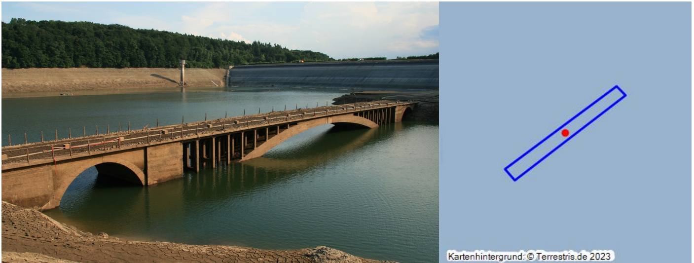
Derenbachtalbrücke im Stauraum der Wahnbachtalsperre, aufgenommen am 2.7.2008 Fotograf/Urheber: Johannes Siebig
