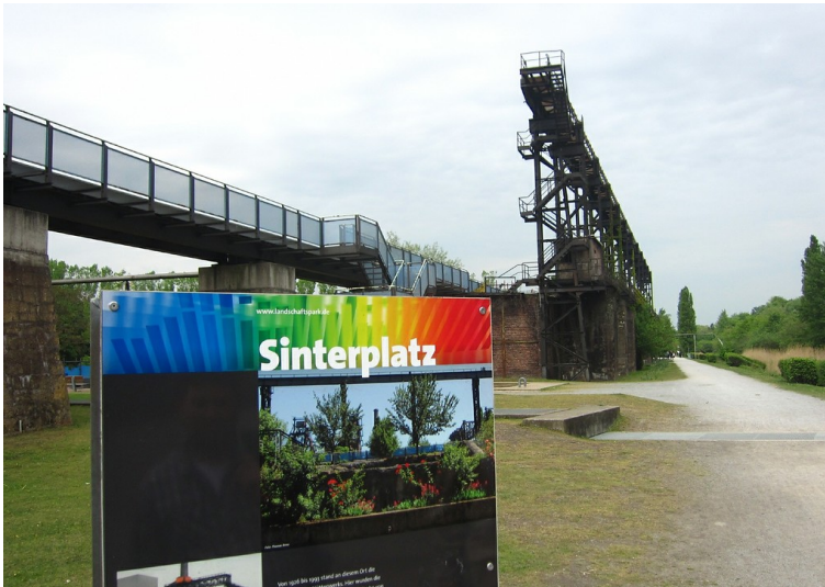
Technische Anlagen eines ehemaligen Sinterplatzes an der Alten Emscher im Landschaftspark Duisburg-Nord (2014). Fotograf/Urheber: Franz-Josef Knöchel
