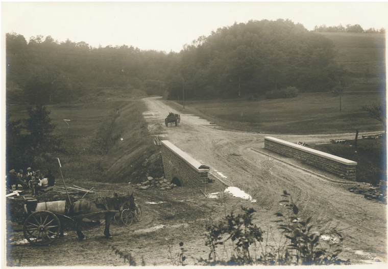
Wahnbachtalstraße während der Bauphase 1925-1927. Blick auf eine Brücke und den anschließenden Straßendamm, der noch nicht fertig gestellt ist. Fotograf/Urheber: unbekannt
