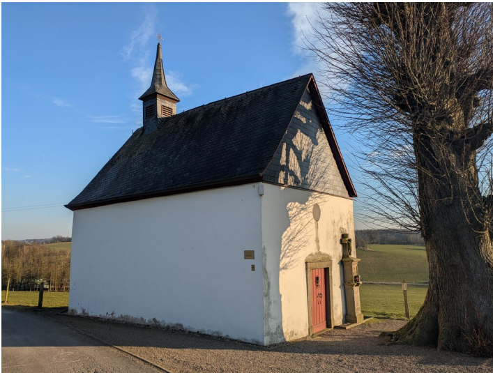
Nord- und Westseite der Kapelle "Zur heiligen Familie" in Oberbreidenbach (2025). Fotograf/Urheber: Samuel Dreßen
