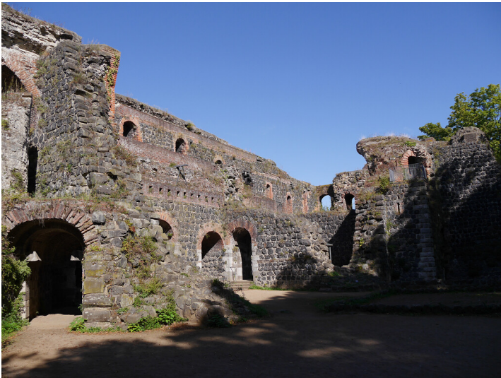
Kaiserpfalz in Kaiserswerth (2019) Fotograf/Urheber: Andje Knaack
