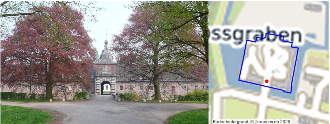
Torgebäude von Schloss Heltorf Fotograf/Urheber: Annette Heusch-Altenstein
