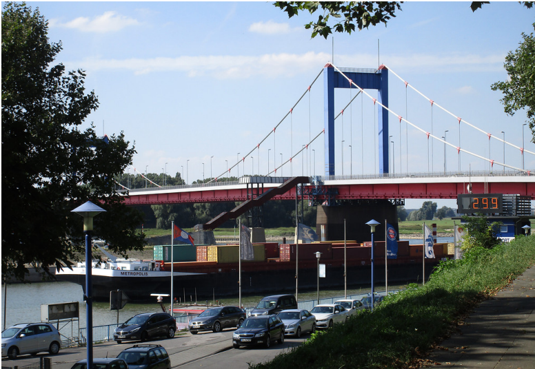
Die Duisburger Friedrich-Ebert-Straßenbrücke über den Rhein zwischen den Stadtteilen Ruhrort und Homberg (2016). Ansicht von Süden, zentral im Bild die 2010 erbaute "Haniel-Treppe" mit Aussichtsplattform, rechts der Rheinpegel.
