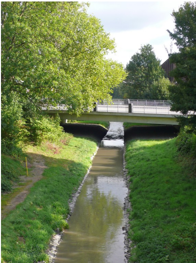
Begradigter Flussverlauf der Emscher in Dortmund (2009) Fotograf/Urheber: Annette Heusch-Altenstein
