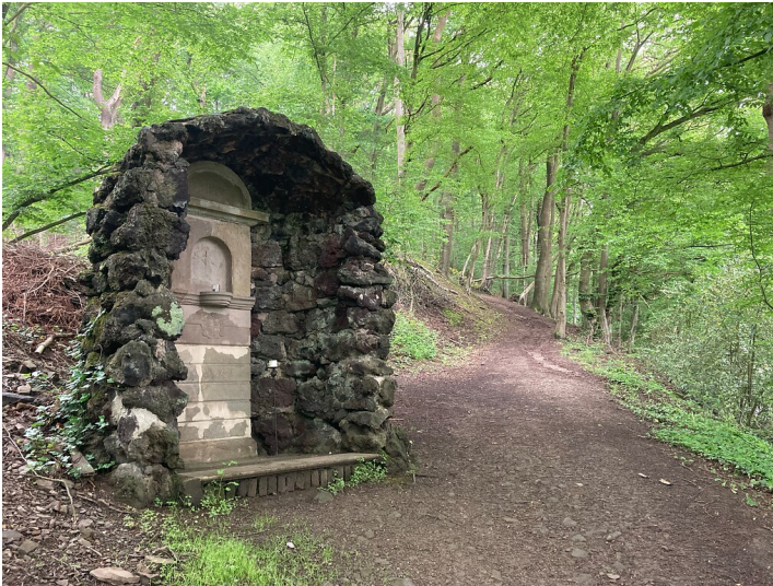
Station Nr. 1 des Fußfallwegs von Overath nach Marialinden mit Wegeverlauf (2021) Fotograf/Urheber: Jan Spiegelberg
