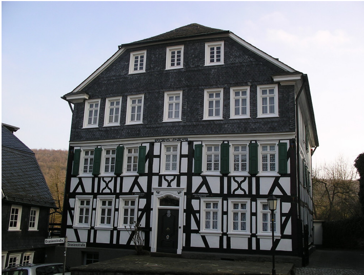
Fachwerkhaus in Freudenberg Fotograf/Urheber: Annette Heusch-Altenstein
