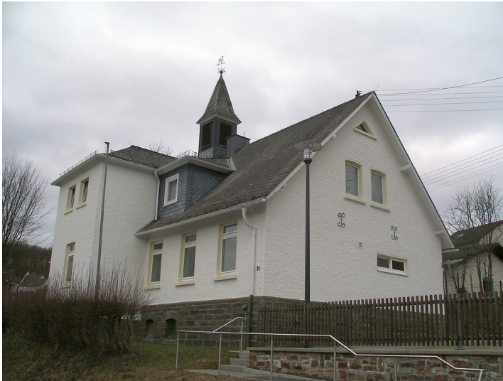
Ehemalige Kapellenschule in Flammersbach, heute Bürgerhaus (2005) Fotograf/Urheber: Annette Heusch-Altenstein
