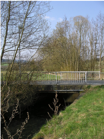
Betonübergang über die Dietzhölze in Steinbrücken (2007) Fotograf/Urheber: Annette Heusch-Altenstein
