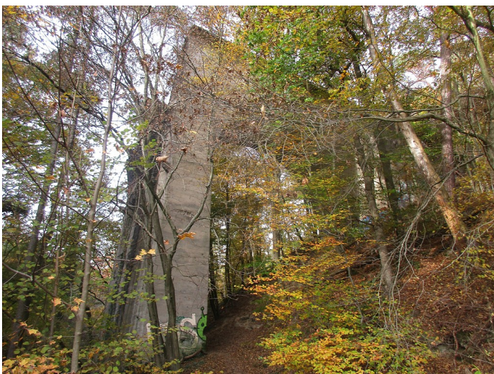
Die Ruine der Ummigstalbrücke bei Siegburg-Seligenthal (2016).
