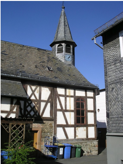
Fachwerkkapelle von Niedereisenhausen (2006) Fotograf/Urheber: Annette Heusch-Altenstein
