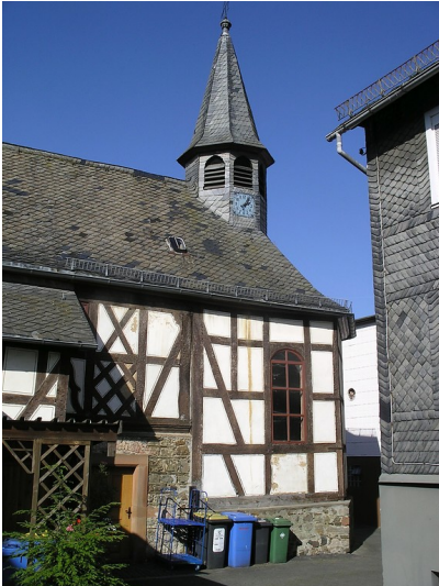
Fachwerkkapelle von Niedereisenhausen (2006) Fotograf/Urheber: Annette Heusch-Altenstein
