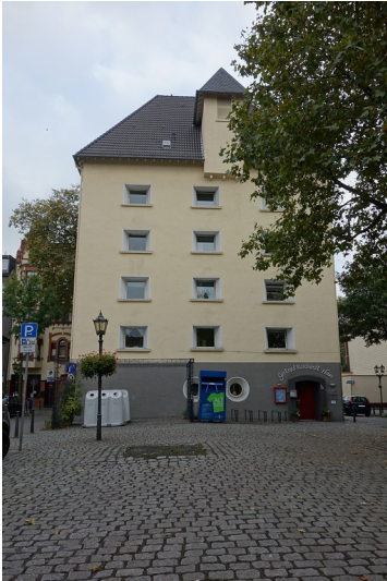
Hochbunker am Neumarkt in Duisburg-Ruhrort (2016) Fotograf/Urheber: Kai-William Boldt
