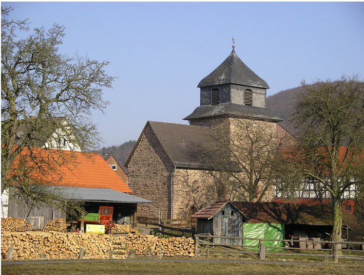
Evangelische Wehrkirche in Dilschhausen (2005) Fotograf/Urheber: Annette Heusch-Altenstein
