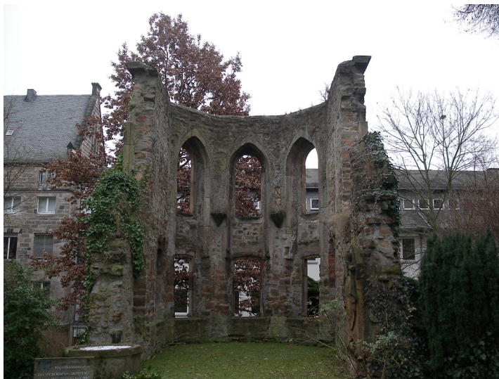
Kapellenruine des Deutschordens-Hospitals in Marburg (2005) Fotograf/Urheber: Annette Heusch-Altenstein
