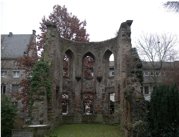
Kapellenruine des Deutschordens-Hospitals in Marburg (2005) Fotograf/Urheber: Annette Heusch-Altenstein
