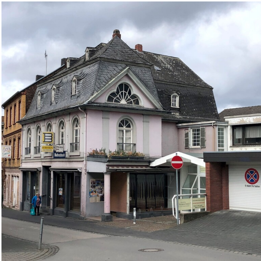
Wohn- und Geschäftshaus Mühlenbachstraße 40 in Sinzig (2023) Fotograf/Urheber: Elmar Knieps
