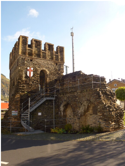
Befestigung Kirchhausen in Oberwesel (2016): Zwischen 1390 und 1448 lässt sich der vierte und letzte Bauabschnitt der Stadtbesfestigung Oberwesels datieren. Hierbei handelt es sich um die südliche Erweiterung der Stadtbesfestigung, dadurch wurden Kirchhausen sowie die Liebfrauenkirche in die Stadtmauer einbezogen Fotograf/Urheber: Kira Bublies
