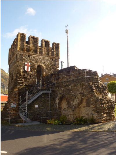
Besfestigung Kirchhausen in Oberwesel (2016): Zwischen 1390 und 1448 lässt sich der vierte und letzte Bauabschnitt der Stadtbesfestigung Oberwesels datieren. Hierbei handelt es sich um die südliche Erweiterung der Stadtbesfestigung, dadurch wurden Kirchhausen sowie die Liebfrauenkirche in die Stadtmauer einbezogen Fotograf/Urheber: Kira Bublies
