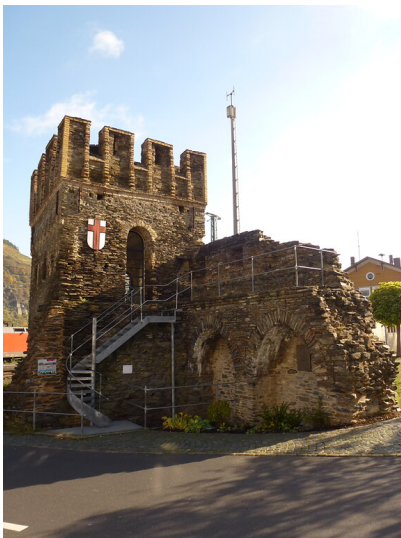
Befestigung Kirchhausen in Oberwesel (2016): Zwischen 1390 und 1448 lässt sich der vierte und letzte Bauabschnitt der Stadtbefestigung Oberwesels datieren. Hierbei handelt es sich um die südliche Erweiterung der Stadtbefestigung, dadurch wurden Kirchhausen sowie die Liebfrauenkirche in die Stadtmauer einbezogen Fotograf/Urheber: Kira Bublies
