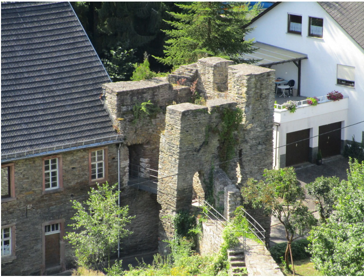
Mühlenturm der Stadtbesfestigung in Oberwesel (2016) Fotograf/Urheber: Kira Bublies
