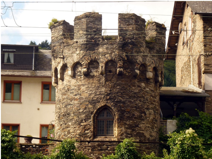
Turm Haus Schönburg der Stadtbefestigung Oberwesel (2016). Fotograf/Urheber: Kira Bublies
