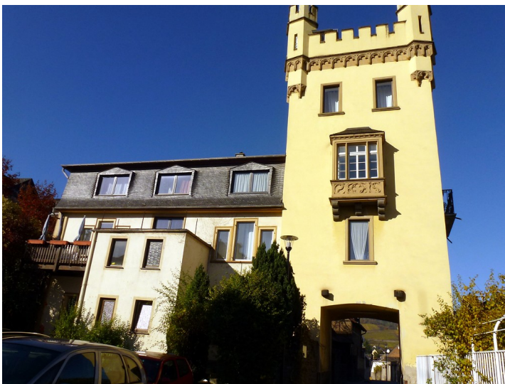
Weißer Turm der Stadtbefestigung Oberwesel (2016): Die Südseite des Turms mit einem Erker, der nach 1863 angebaut wurde. Fotograf/Urheber: Kira Bublies
