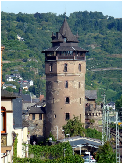
Roter Turm der Stadtbefestigung Oberwesel (2016): Blick auf den Roten Turm. Fotograf/Urheber: Anne Gasper
