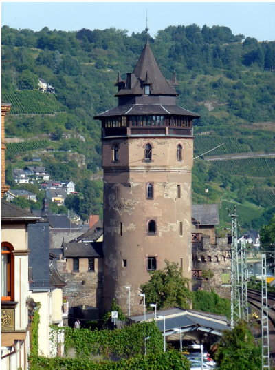
Roter Turm der Stadtbefestigung Oberwesel (2016): Blick auf den Roten Turm. Fotograf/Urheber: Anne Gasper
