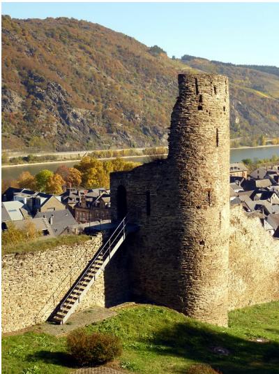
Pulverturm der Stadtbefestigung von Oberwesel (2016): Der Pulverturm ist der einzige halbrunde Schalenturm mit kegelförmigem Dachhelm der bergseitigen Stadtbefestigung. Fotograf/Urheber: Kira Bublies
