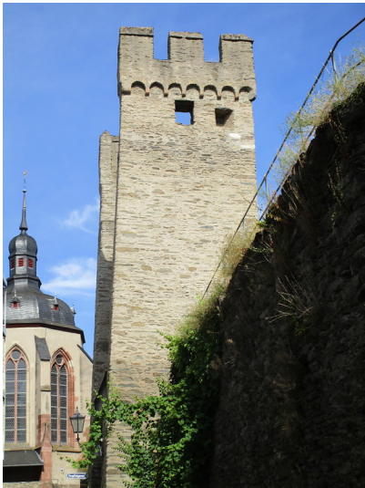
Der Hospitalturm in Oberwesel (2016) Fotograf/Urheber: Kira Bublies
