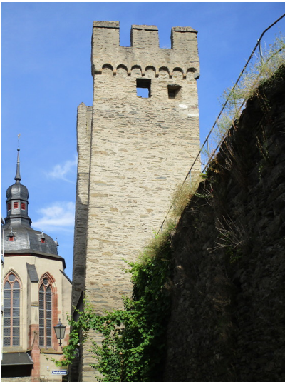
Der Hospitalturm in Oberwesel (2016) Fotograf/Urheber: Kira Bublies
