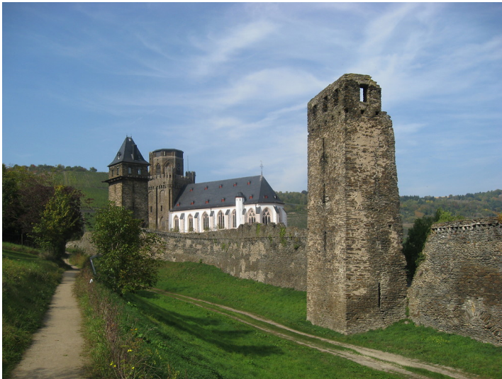
Mittelalterliche Stadtbefestigung in Oberwesel (2016) Fotograf/Urheber: Kira Bublies
