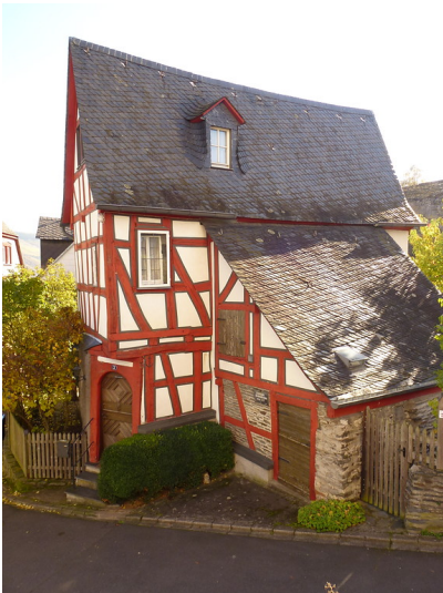
Küsterhaus am Martinsberg 3 in Oberwesel (2016): Das Haus am Martinsberg stammt aus 1625, das oxidrot des Fachwerks ist typisch für den Baustil des Mittelrheintals. Fotograf/Urheber: Kira Bublies
