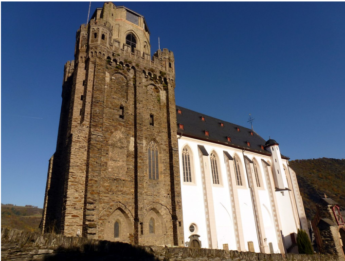
St. Martinskirche Oberwesel (2016): Der Turm der Kirche hat mit den Schießscharten auch eine Wehrfunktion. Fotograf/Urheber: Kira Bublies
