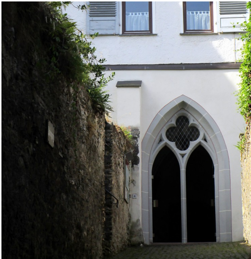
Sakristei im Minoritenkloster Oberwesel (2016): Die Sakristei wird heute über den Patergang betreten. Fotograf/Urheber: Kira Bublies
