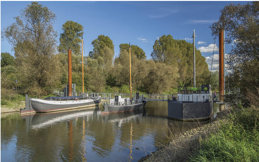
Schiffsbrücke an der alten Wuppermündung in Leverkusen-Rheindorf Fotograf/Urheber: Holger Klaes
