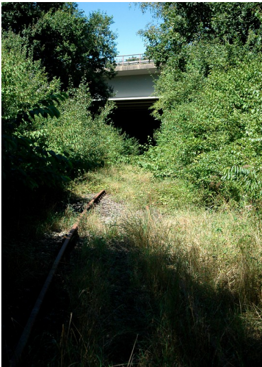
Seitenansicht der Straßenbrücke zur Überquerung der Hochwaldbahn bei Nonnweiler (2016). Fotograf/Urheber: Jan Opgenoorth
