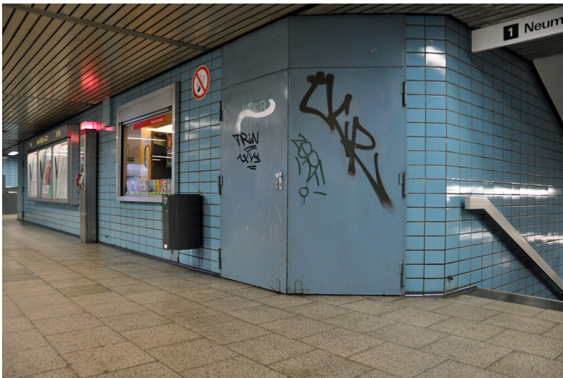
Eingang zum Atombunker auf der Zwischenebene der Haltestelle Kalk Post in Köln-Kalk (2020). Fotograf/Urheber: Katharina Grünwald
