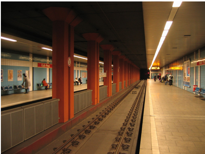
Bahnsteig und Gleisanlage im U-Bahnhof Kalk Post der Stadtbahn Köln (2008); zur Zeit des "Kalten Krieges" zugleich Zugang zu einer Zivilschutzanlage mit Atombunker. Fotograf/Urheber: ReferenceBK
