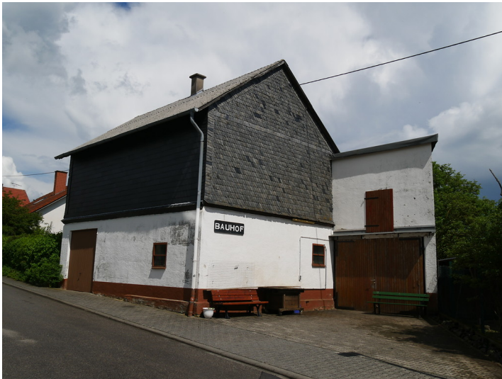
Bauhof der Gemeinde Dörrebach, Blickrichtung Westen (2017) Fotograf/Urheber: Jörn Schultheiß
