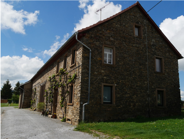
Hauptgebäude des Landwirtschaftsbetriebes "Im Pfädchen 10" in Dörrebach, Blickrichtung Nordwesten (2017) Fotograf/Urheber: Jörn Schultheiß
