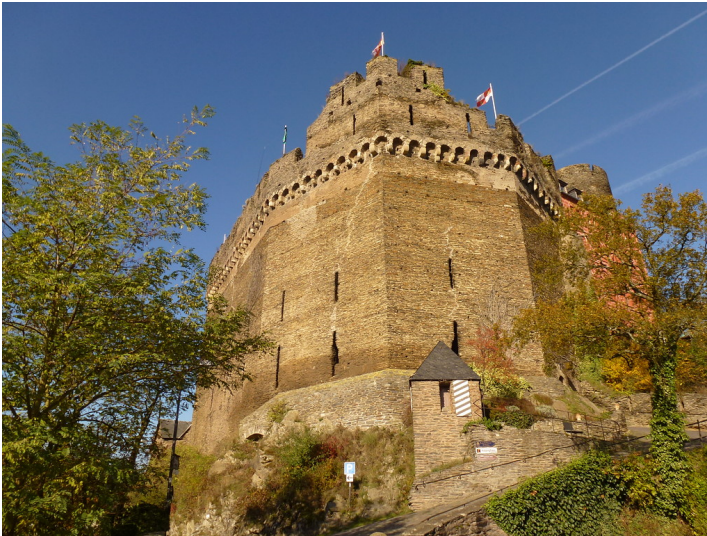
Schutzwall Hoher Mantel der Schönburg Oberwesel (2016) Fotograf/Urheber: Anne Gasper
