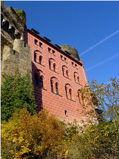
Südlicher Palas der Schönburg in Oberwesel (2016) Fotograf/Urheber: Anne Gasper
