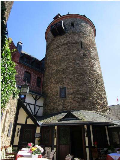
Barbarossaturm der Schönburg in Oberwesel (2016) Fotograf/Urheber: Kira Bublies
