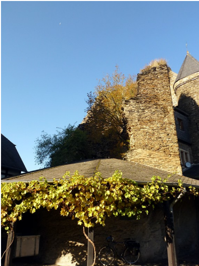
Siebeneckiger Turm der Schönburg Oberwesel (2016) Fotograf/Urheber: Anne Gasper
