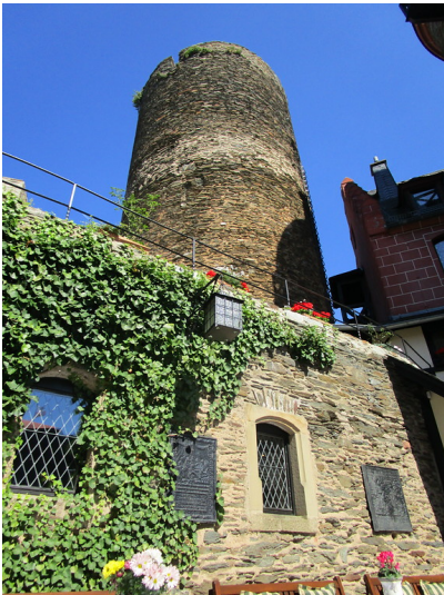
Gefängnisturm in Oberwesel (2016) Fotograf/Urheber: Kira Bublies
