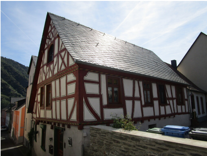
Wohnhaus in der Borngasse 2 in Oberwesel (2016) Fotograf/Urheber: Anne Gasper
