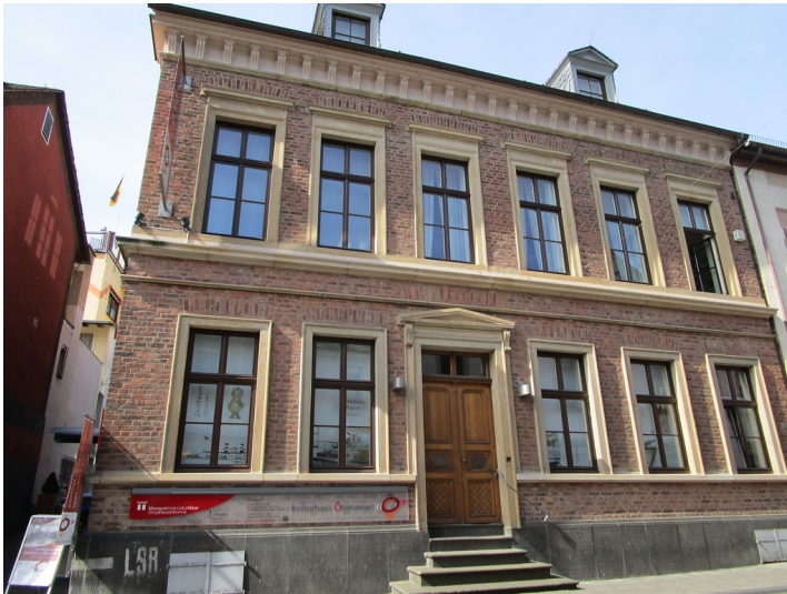
Kulturhaus in Oberwesel (2016): Die Fassade besteht aus rotem Backstein, die Gesimse sowie Tür- und Fenstergewände sind aus gelbem Sandstein gefertigt. Fotograf/Urheber: Kira Bublies
