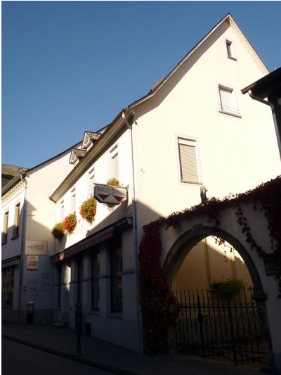
Wohnhaus an der Rathausstraße 16 in Oberwesel (2016): Zu dem Haus gehört auch ein Hof, über den das Haus betreten werden kann. Fotograf/Urheber: Anne Gasper
